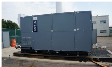
GT 333 Turbinás egység 333 kW teljesítménnyel
